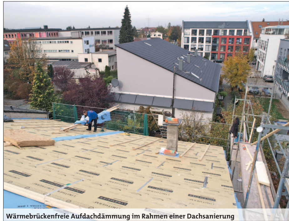
Wärmebrückenfreie Aufdachdämmung im Rahmen einer Dachsanierung
