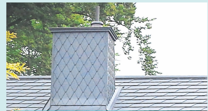
Prefa Metaldacheindeckung inklusive aluminiumbeschichteter Kaminverkleidung.
