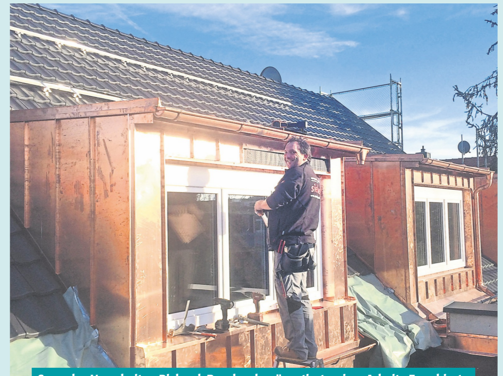
Spengler-Vorarbeiter Richard Bernhard präsentiert seine Arbeit: Engobierte Flachdachpfanne mit Kupfergaube.
